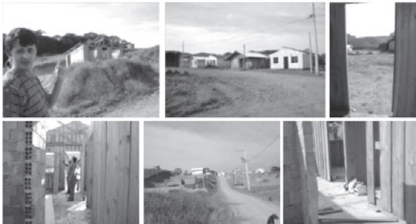
Fotos 31 a 36: O conjunto habitacional dos Baús é um exemplo de descompromisso com a recuperação dos grupos mais severamente afetados da localidade: obras interrompidas e tomadas pelo mato; madeira de baixa qualidade; terraplanagem, que vai se perdendo sem os muros de contenção nos terrenos. As crianças brincam em meio aos espaços de abandono (Fonte: Acervo do Neped, julho de 2011).
