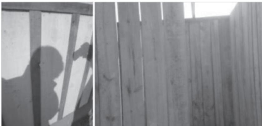
Fotos 39 e 40: Madeira enodoadada para a formação das paredes das casas no conjunto habitacional nos Baús: a obra que seque foi entregue terá uma durabilidade mínima, devido o descaso com a qualidade do material (Fonte: Acervo do Neped, julho de 2011).
