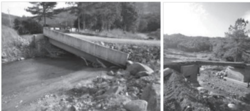
Fotos 21 e 22: Aspectos de duas pontes na Região dos Baús, ambas comprometidas e fonte de risco para o tráfego de pessoas e veículos (Fonte: Acervo do Neped, julho de 2011).
